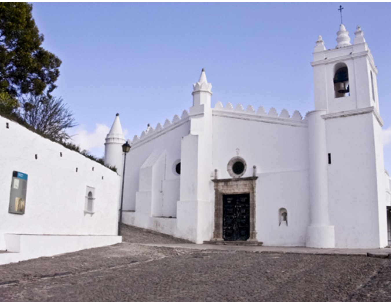
Fachada da Igreja matriz de Mértola (foto SGM).
