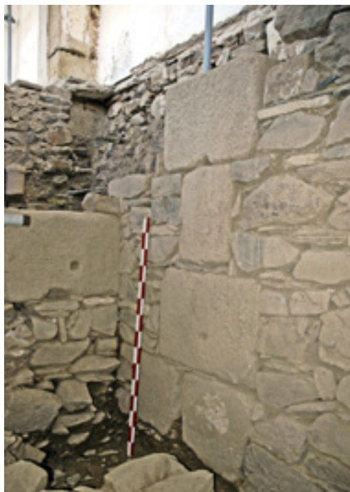
Muros do edifício da Antiguidade Tardia anterior à Mesquita (foto SGM).
